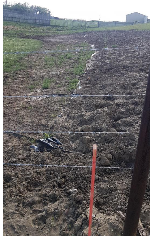
Figure 4 - Site d'excavation à proximité d'une propriété privée
